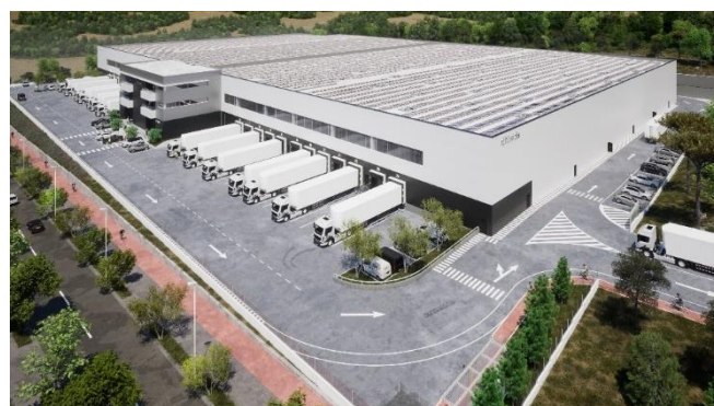
Figura 1 – Imagen de instalaciones del proyecto Xamenes
